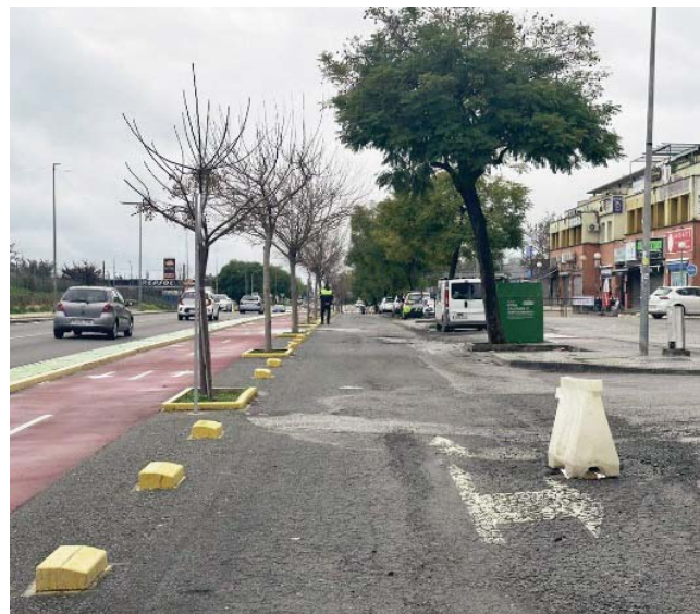
Reasfaltado de la A-474. AYTO BORMUJOS
